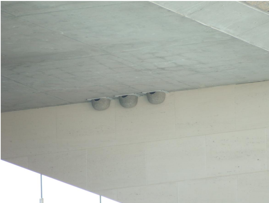
Nius artificials instal·lats a la Biblioteca Municipal. Juny 2018.
