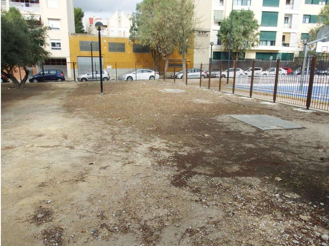
Ubicació de bassa de fang projectada però sense construir al Jutjat de Pau. Juny 2018.
